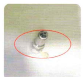
〈방전감지기 내부 소화기 노즐 설치〉
