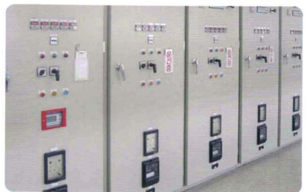
〈멀티시스템 배전반 설치 : OO정수장〉
